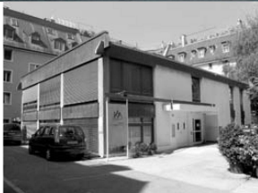
^ Das Haus vor dem Umbau.
