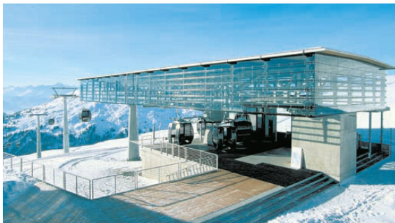
« Gestaltete Hülle: die Bergstation der Gondelbahn Nagens bei Flims von Marcus Gross und Werner Rüegg von 1997.
