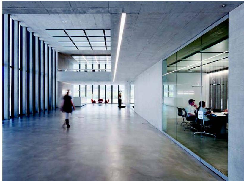
^Reduktion heisst, sich – mit Ausnahme des Stahlträgers über der Produktionshalle – auf drei Materialien zu beschränken: Sichtbeton, Glas und blankes Aluminium.
