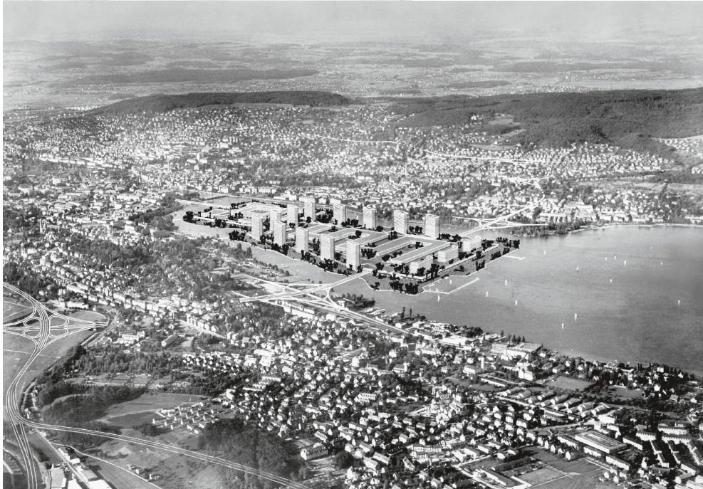
^13_Der See als Grossbauplatz. «City im See», 1961.
