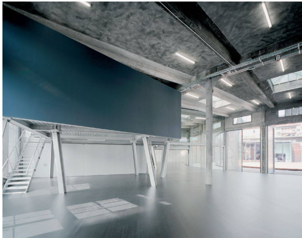
^Die aufgeständerte Box birgt die Garderoben und die Maske des Theaters. Schräge Stützen stabilisieren die Stahlkonstruktion. Der durchgehende Bühnenboden macht die gesamte Theaterzone frei bespielbar. Foto: Walter Mair
