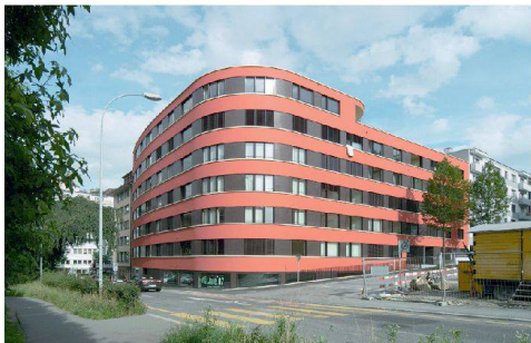
23_Wohn- und Geschäftshaus Linie07. Foto: Louis Brem
