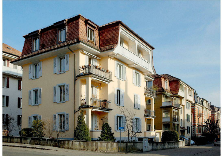
^Das Vorbild: eine Stadtvilla im Obstbergquartier.
