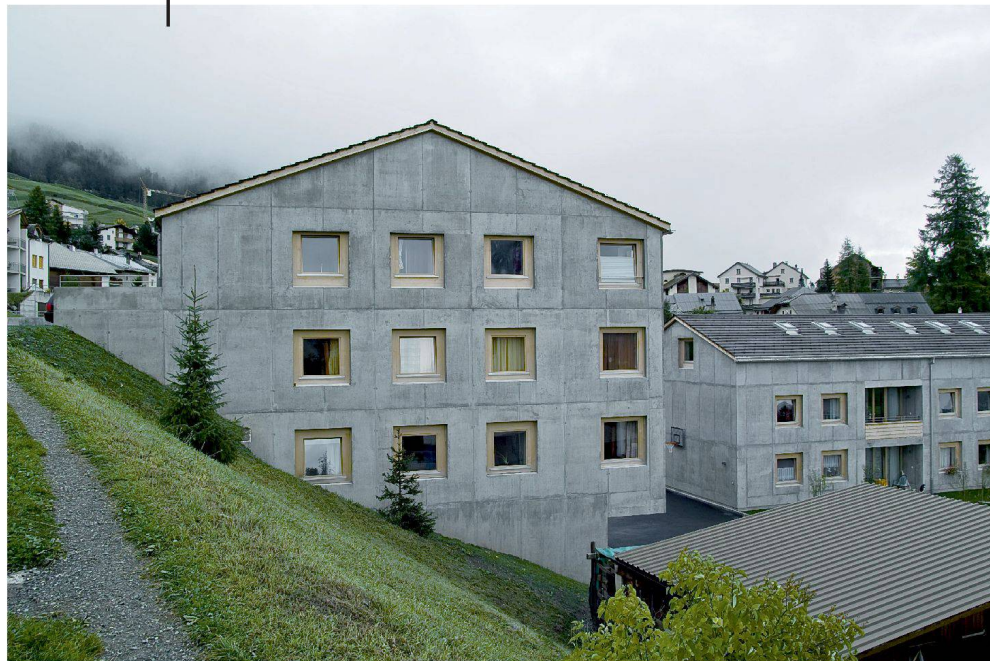
^ Im Engadiner Bergdorf Ftan nicht üblich: Sichtbetonfassade mit strengem Raster.
