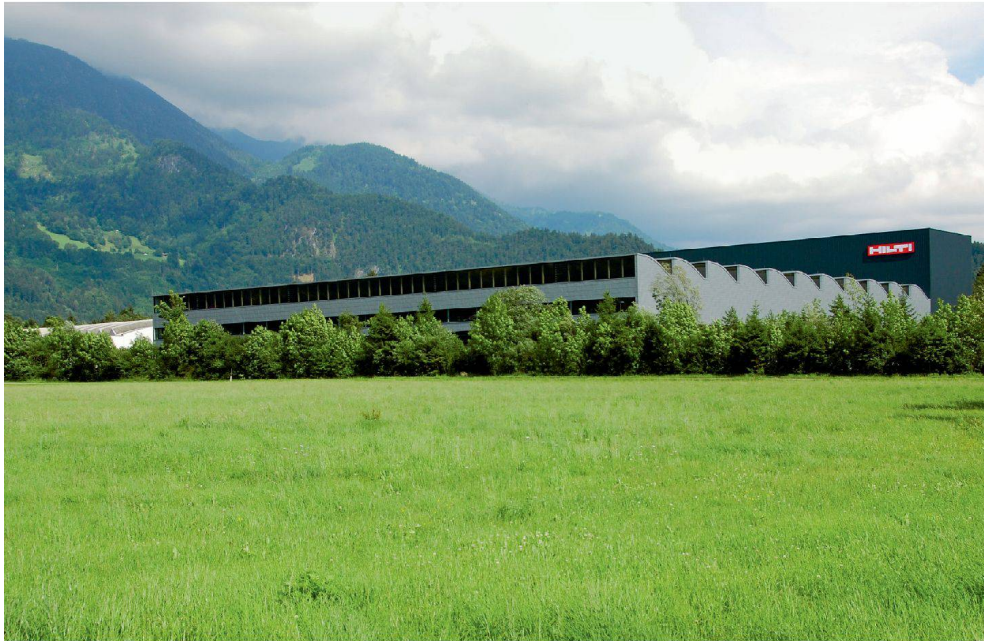
^Die neue Halle vor dem Thüringer Hochregallager. ^The new hall in front of the high rack warehouse in Thüringen.
