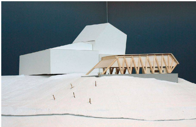
▼ Mierta Feuerstein: Bergstation als Leichtbau aus Fichtenholz.
