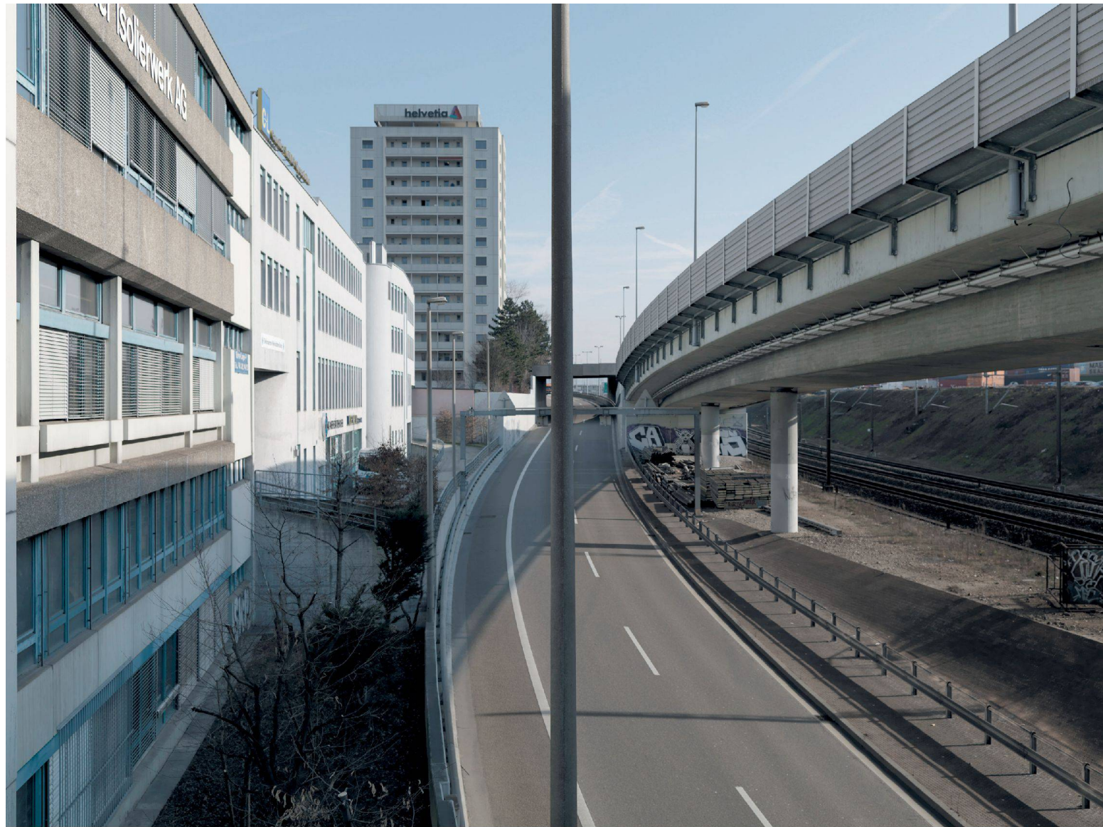
^Das Haus aufzustocken war statisch nicht möglich. Dafür verleiht ihm eine neue Krone einen Hauch mehr Höhe.
