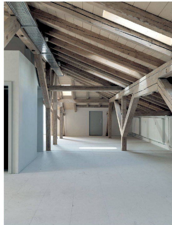
^ Der ausgebauter Dachstock.
