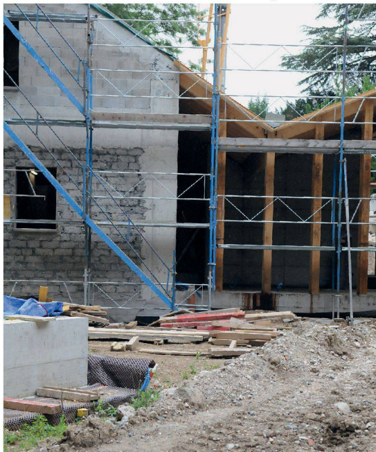
↳ Mut zur traditionellen Form: Wohnhauserweiterung in Troinex.
