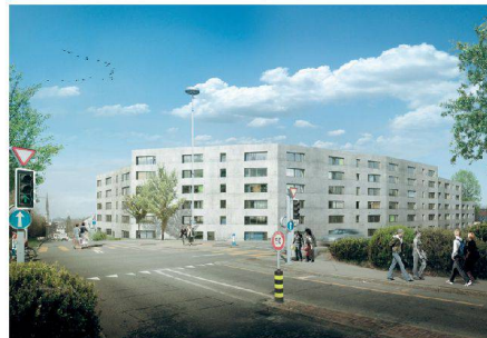
^20_Winterthurerstrasse Etappe A
