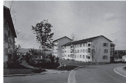
^2_Die abgebrochenen Häuser der Siedlung Albisrieden.
