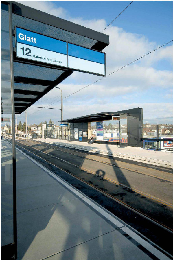
^49_Glattalbahn: Die Gestaltung der Haltestellen mit ihren behindertengerechten Hochkanten prägt das ganze Netz.
