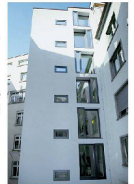
<4_Geschäftshaus Blumenbergplatz, Attikageschoss.
