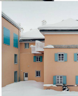
42 _ Neubauten im Dorf Pontresina. Foto: Rasmus Norlander
