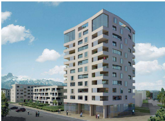
^16_Wohnüberbauung Selve, im Bau.
