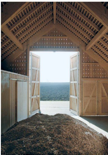
<9_«Pflicht und Kür»: Die Münchner N-V-O Architekten bauen ein Zweckgebäude und sägen anschließend ein Lochmuster in die Fassade (2008).
