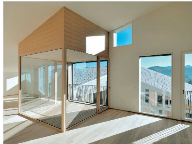
^Nach aussen und innen verglaste Loggien unterteilen die grosszügigen Wohnräume und bilden Klimapufferzonen.
