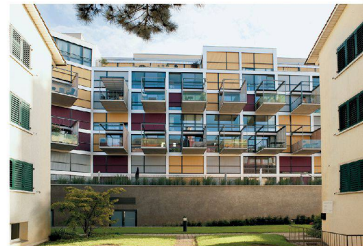
^ Rückseite: Wohnräume hinter verglaster Fassade.
