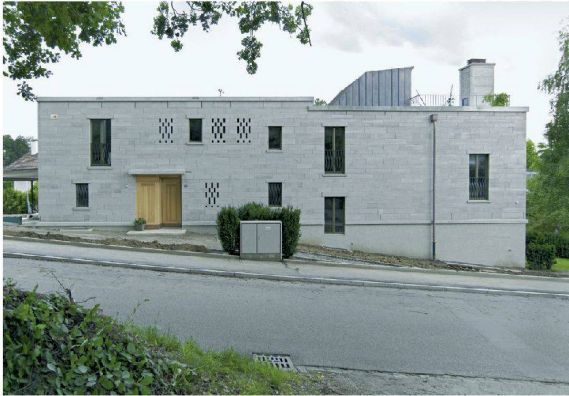
^27_ Muschelkalkblöcke prägen das Gesicht zur Strasse hin.
