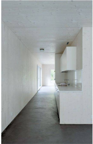
<23_ Die vorgefertigten Holzelemente wurden mit Dreischichtplatten beplankt.
