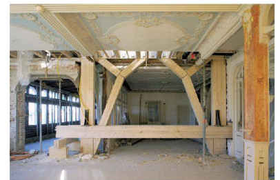
^31_ Erdbenerüttigung in Holz.
