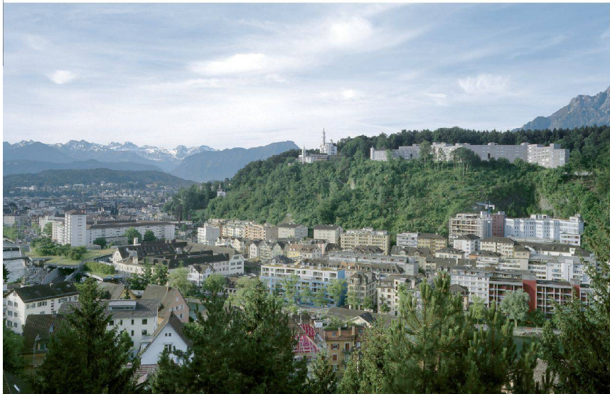
^Das lange, abgeknickte Wohnhaus liegt hoch über der Stadt.
