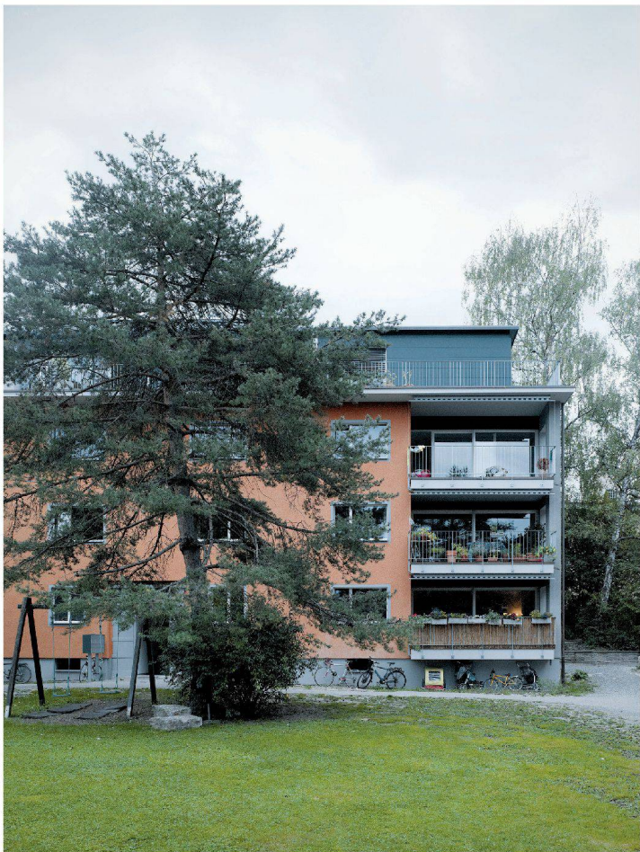
^Das brandbeschädigte Haus erweiterte man nach oben und zur Seite.
