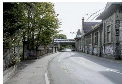
>...und bei der nördlichen Rückseite, der Schützenmattstrasse.
