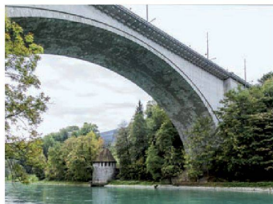
<Die Lorrainebrücke und der Bluturm vom anderen Ufer aus gesehen.
