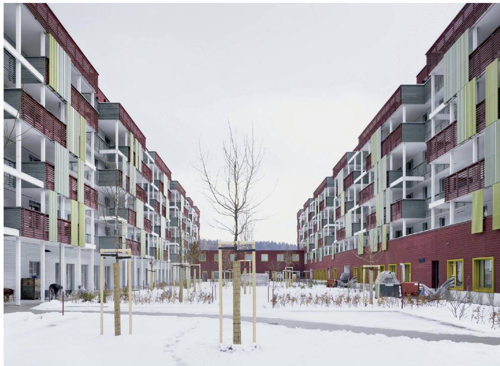
^Das Miteinander wird grossgeschrieben. Der Hof ist dafür der Dreh- und Angelpunkt.
