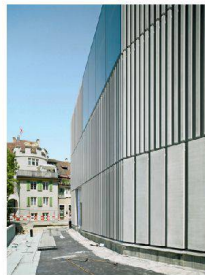
Rippen beleben die geschlossenen Fassaden.
