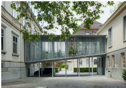
Die heitere, leichtfüssige Passerelle wird abgebrochen werden.
