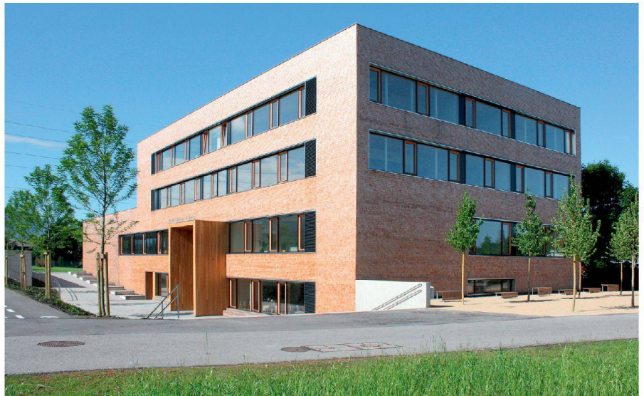
Eine neue Schindelfassade hüllt die Schule in Wolfurt ein. | A new shingle façade wraps around the school in Wolfurt.
