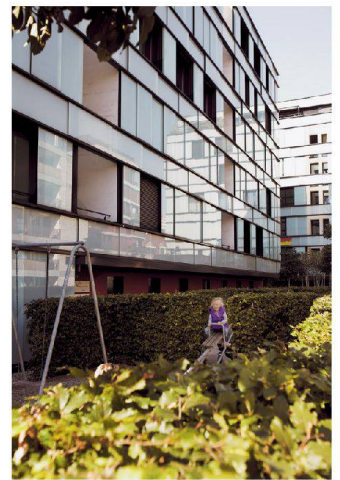
Die verschiebbaren Gläser erzeugen ein wechselndes Fassadenbild.
