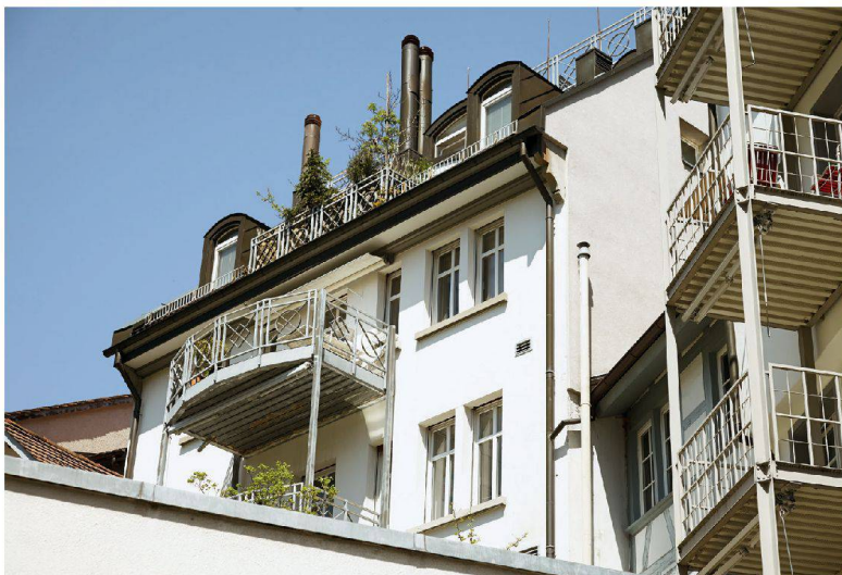
Sanierung Spisergasse, St. Gallen, 1988. Architektur: Senn.
