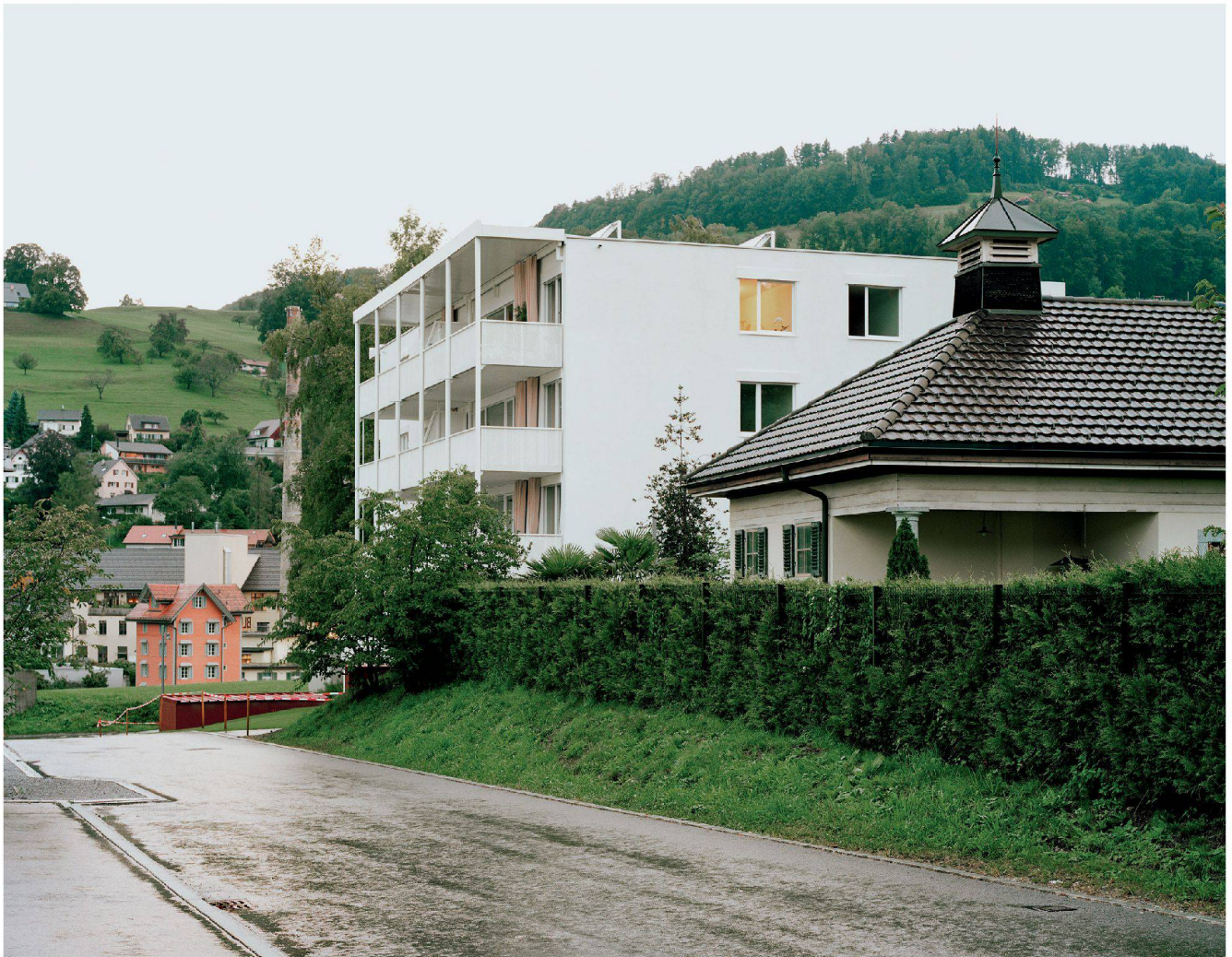
Gemeinde Wald im Zürcher Oberland: Hinten reckt sich ein kleines, rotes Kosthaus zur grünen Kuppe des Bachtel hinauf, vorn präsentiert sich das neue Wohnhaus mit seinen Loggien zur Strasse.
