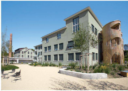
In mehreren Etappen entstanden, heute bewohnt: die Forsanose-Fabrik in Volketswil.
