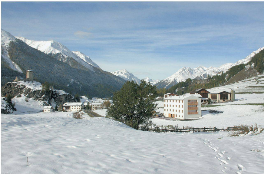
Das Haus prägt den nordöstlichen Ortseingang von Ardez.
