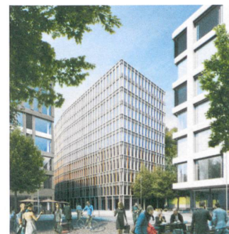
Feingliedrig prägt der Raster das hintere Gebäude.
