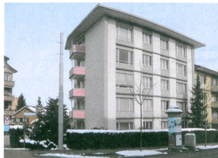
Bieder, aber mit Würde: das Haus vor der Sanierung.
