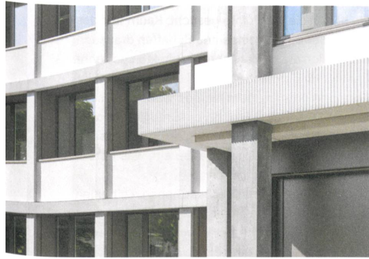
Neue Fassadenstruktur am Westtrakt, im Vordergrund eine Ecke der Bibliothek und der Mensa.
