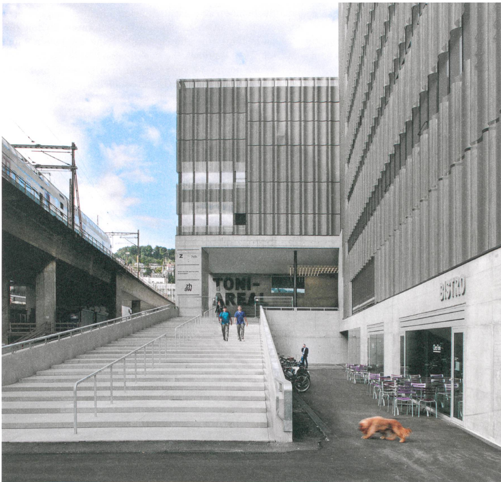
Komm herein: Eine wuchtige Freitreppe führt die Besucher von der Tramhaltestelle zum Eingang.
