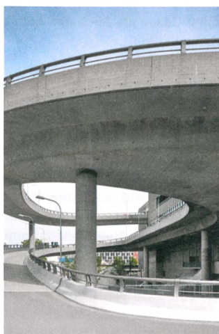
Die Lastwagenrampe wird zum Boulevard.
