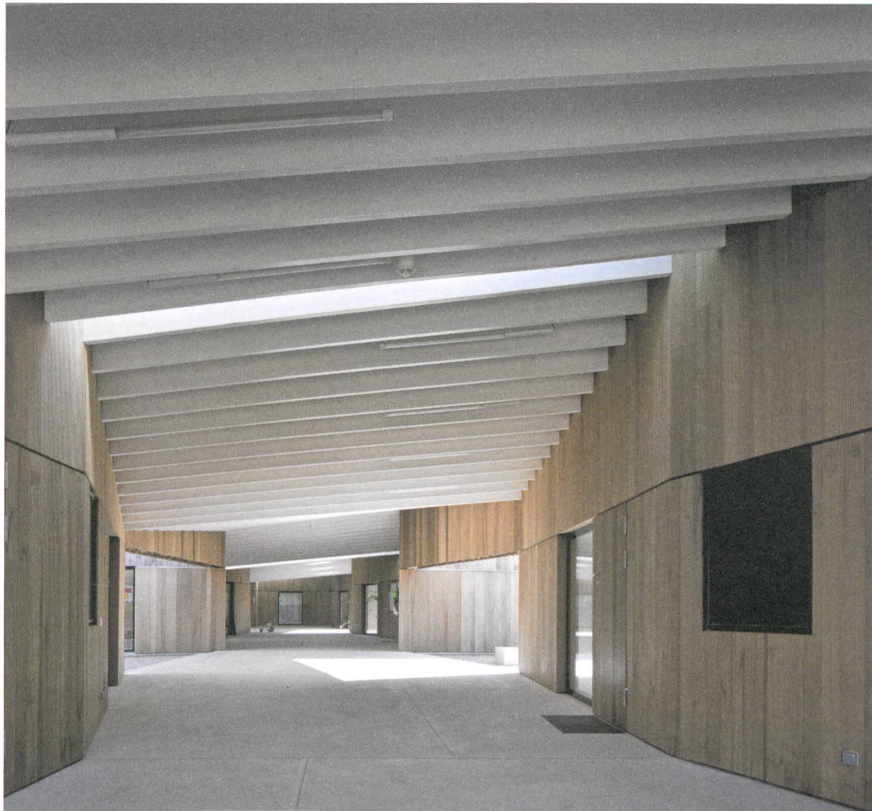
Pufferzone: Der unbeheizte Flur erschliesst die fünf Kindergruppen in der Mitte des Gebäudes.
