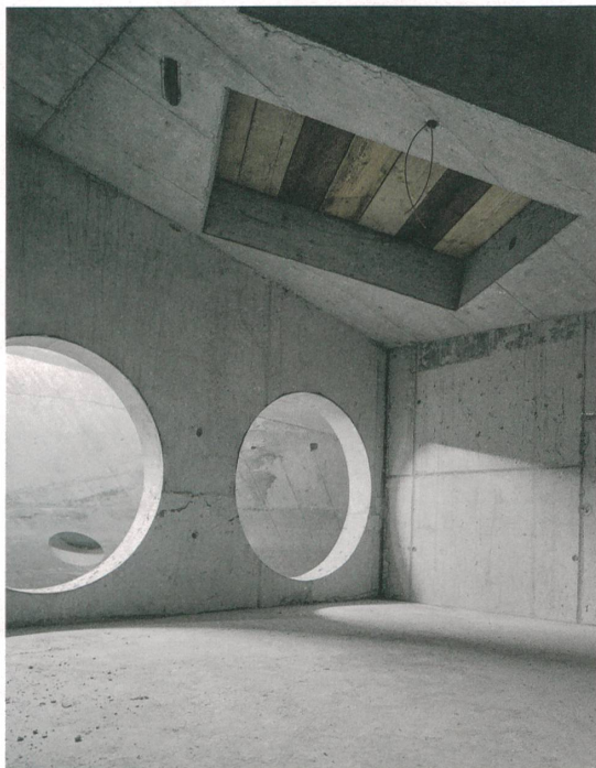
Keine Bullaugenfenster, sondern Löcher für die Rauchgasventilatoren. Im Dach klappt eine temporäre Öffnung. Durch sie werden die Schalungen nach Abschluss des Rohbaus aus dem Gebäude transportiert.
