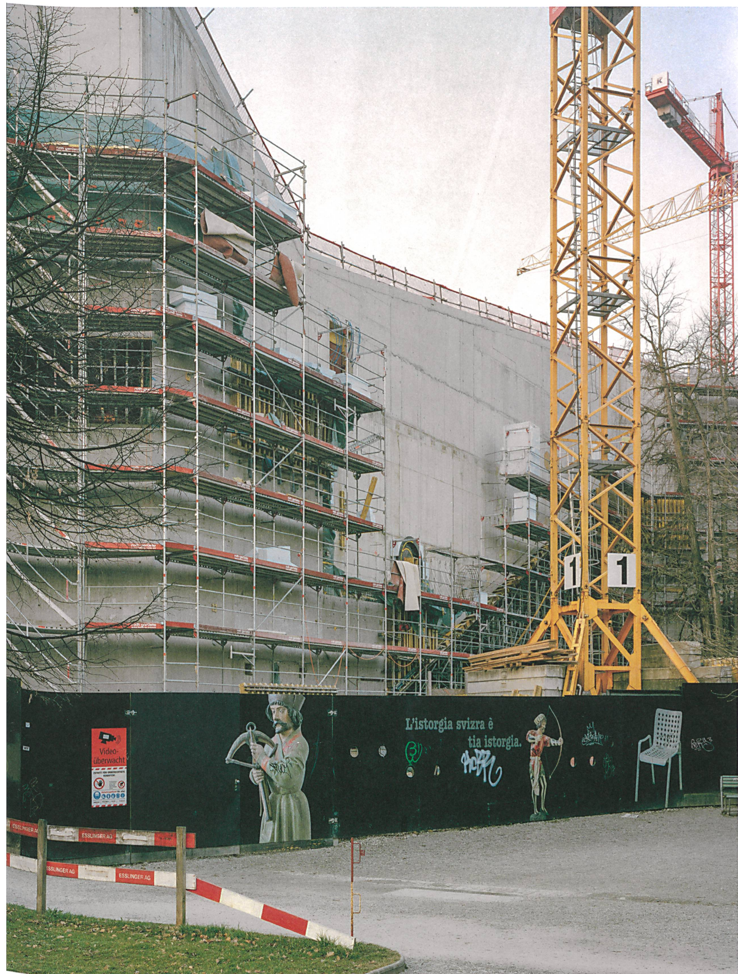
Abgetreppter Betonierablauf: Die fugenlose Aussenschale wird etappenweise von unten nach oben gegossen. Nur so kann der Beton gleichmässig verdichtet werden. ...
