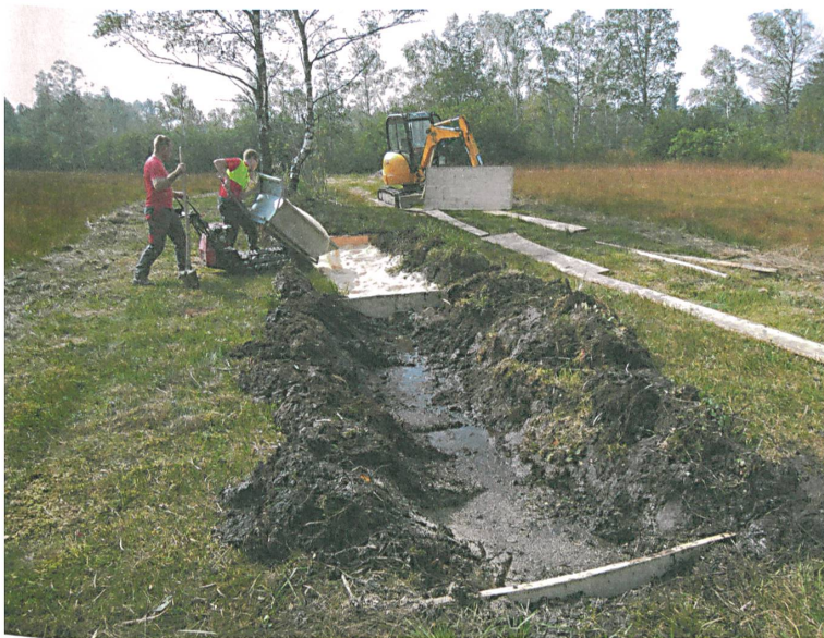
Dann werden die eingestauten Gräben mit frischem Sägemehl aufgefüllt. Es ist nährstoffarm, formstabil, überall vorhanden und einfach zu handhaben.
