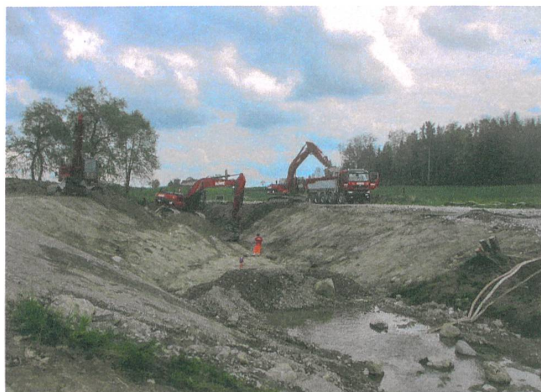
Nachher: Die Böschungen sind abgeflacht, das Bachbett ist aufgeweitet.
