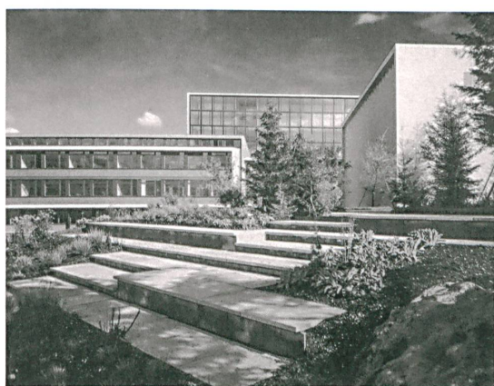
Im Studiengarten werden die Sitzstufen erneuert.
