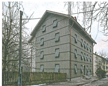
16 Bretterschuppen kleiden die Fassade neu ein.
