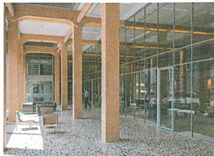
22 Die Verdickung der Zangenbalken und ein Bolzen aus Buchenholz sorgen für steife Verbindungen ohne ein einziges Metallteil.
