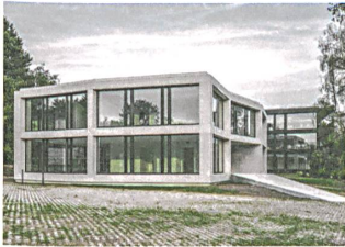
Verwaltungsgebäude und Wohnhaus in St-Sulpice Fruehauf, Henry & Viladoms
