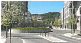
Sanierung und Gestaltung der Kantonstrasse in Au / Widnau Neo Architektur
