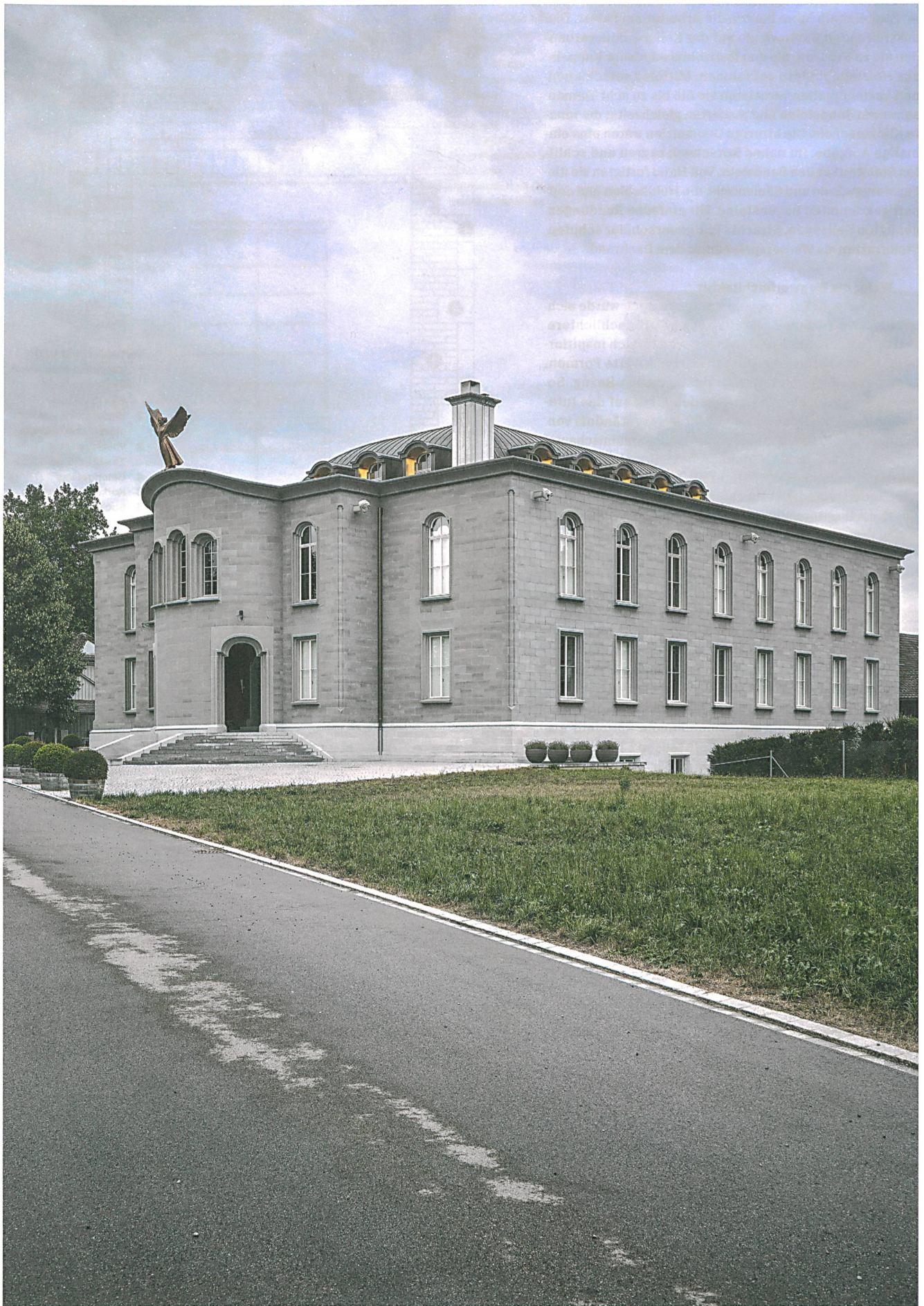
Gebaut für 300 Jahre: Der Modelhof ist ein architektonisches Kuriosum, doch energietechnisch ist die massive Verbundkonstruktion aus Sandstein und Vollklinker interessant.
