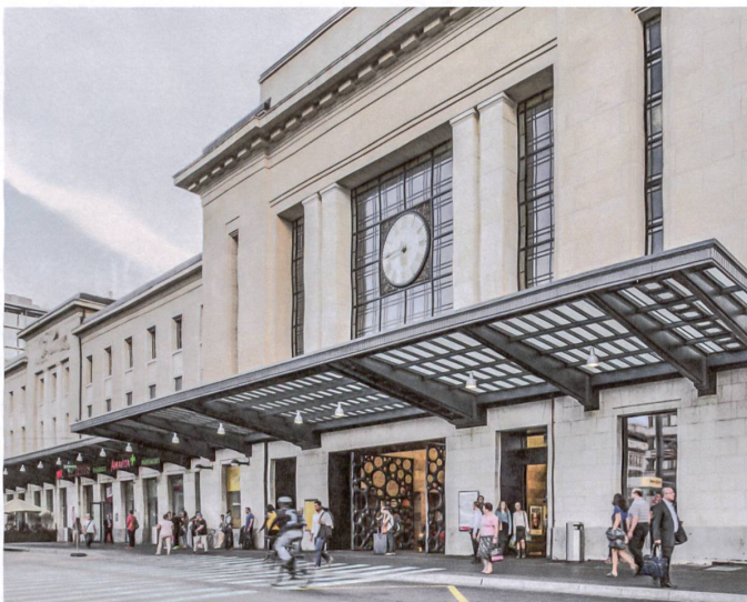
Am Übergang vom Art déco zur Moderne: die Fassade des Genfer Bahnhofs Cornavin.
