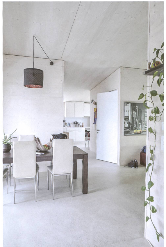
Holzdecke und -wände, Anhydritboden: Die Wohnungen von 2015 sind wesentlich ruhiger.
