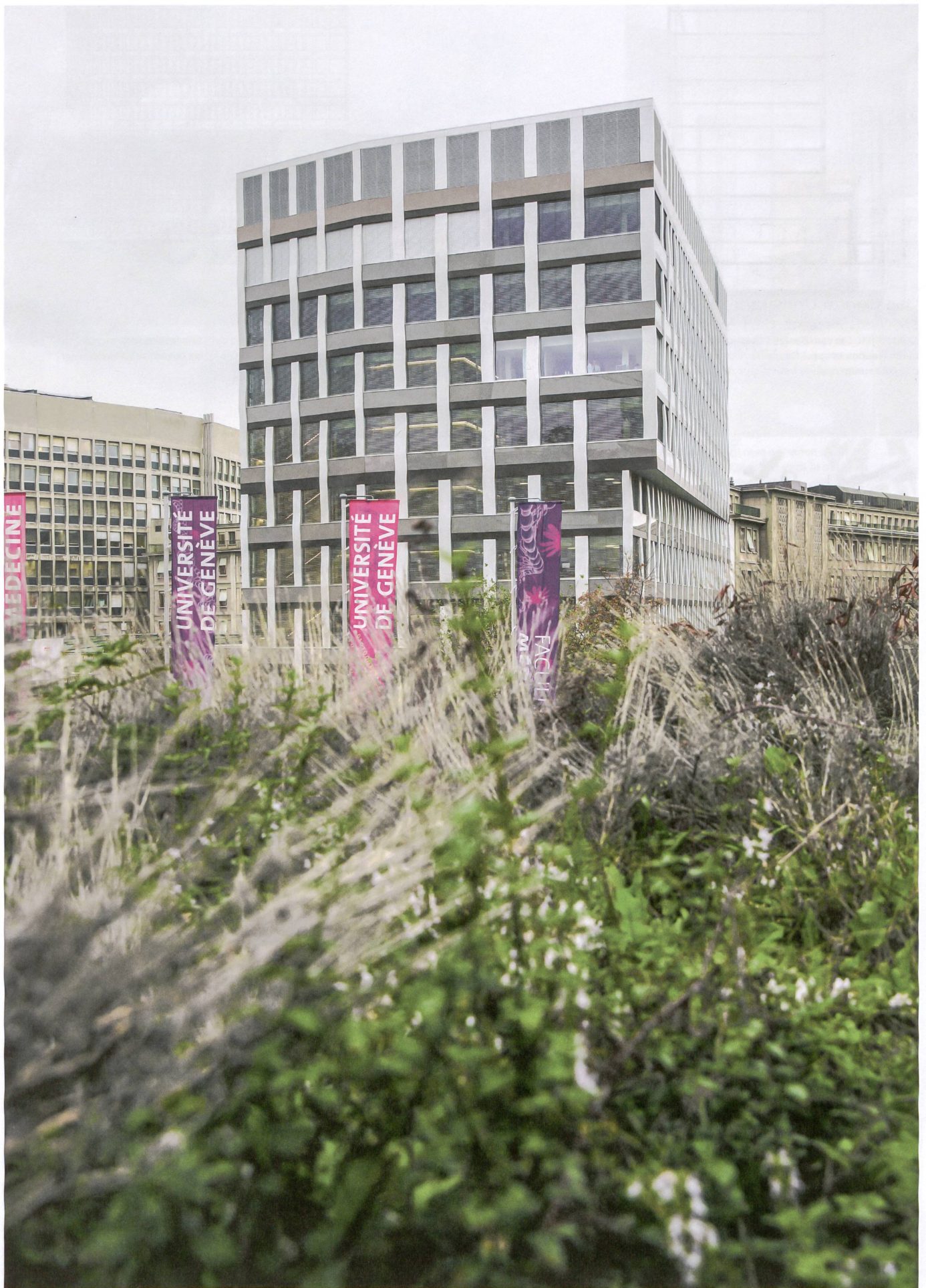
Das Laborgebäude: ein Eckpfeiler auf dem Areal des Genfer Unispitals. | Le bâtiment de laboratoires: un pilier d'angle sur le site des Hôpitaux Universitaires de Genève.
