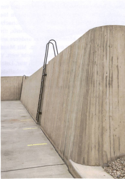
Zwei Schalungstexturen: Das Kraftwerk und die Brücken zeigen Spuren geordneter Schalungstafeln, die Stützmauern und Brückenaufleger überzieht das Abbild verschieden breiter, sägeroher Bretter.
