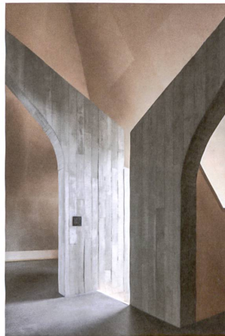
Die Äste des Betonbaums im Dachgeschoss.
